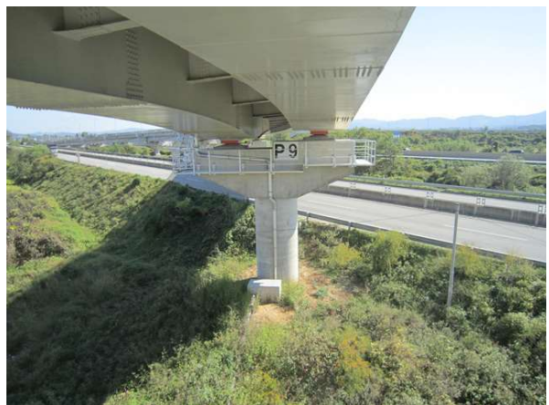
교량 하부 전경
