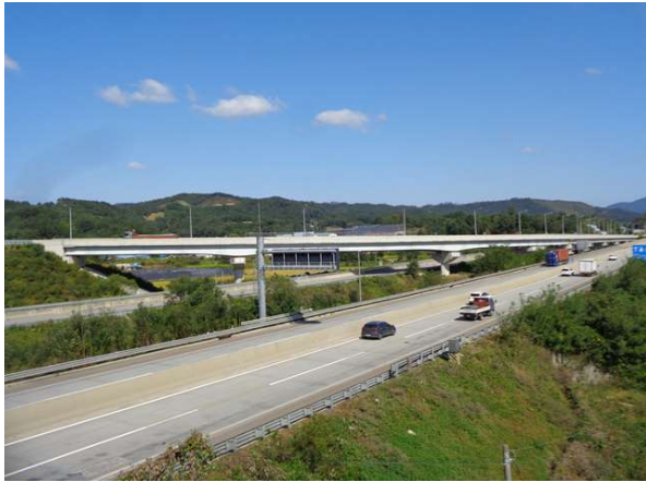
교량 측면 전경
