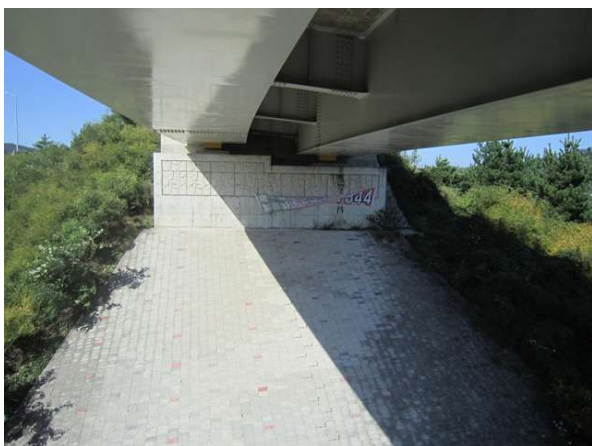
교량 하부 전경
