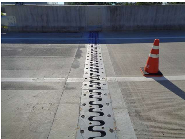
교량 상부 전경
