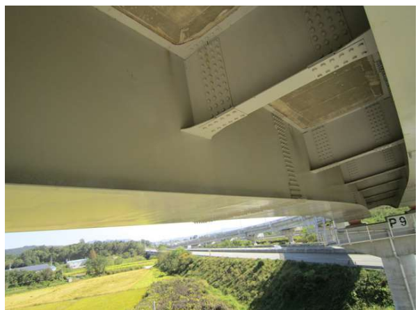
교량 거더 전경
