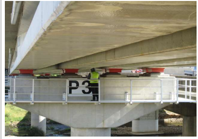
▲ 교량받침 점검로 근접조사
