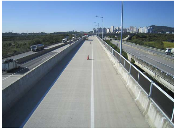
교량 상부 전경
